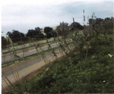
Figure 63 route national n*11 (source : auteur)
