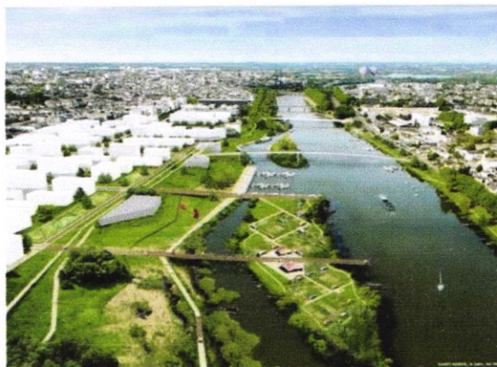
FIGURE02 aménagement des berges d'un canal a la ville de Nancy en France (source:www.skyscrapercity.com )
