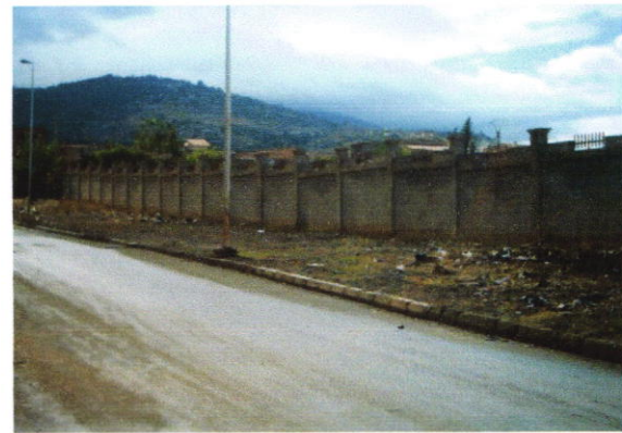
FIGURE06 mur de clôture de notre université (source: auteur)
