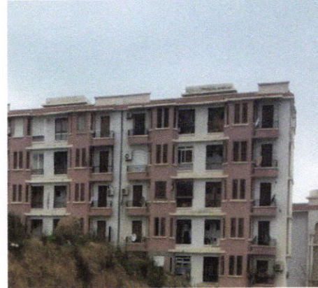
Figure 66 densification des cités d'ortoir (source : auteur)
