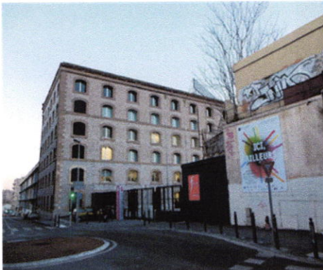
FIGURE37 photo du quartier (source: belle de mai photographie)
