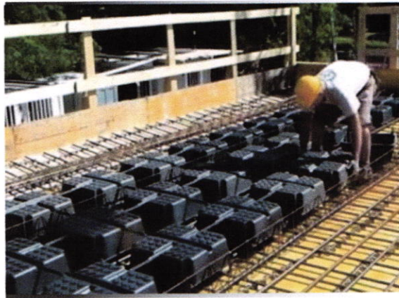
-figure : technique de mise en oeuvre
