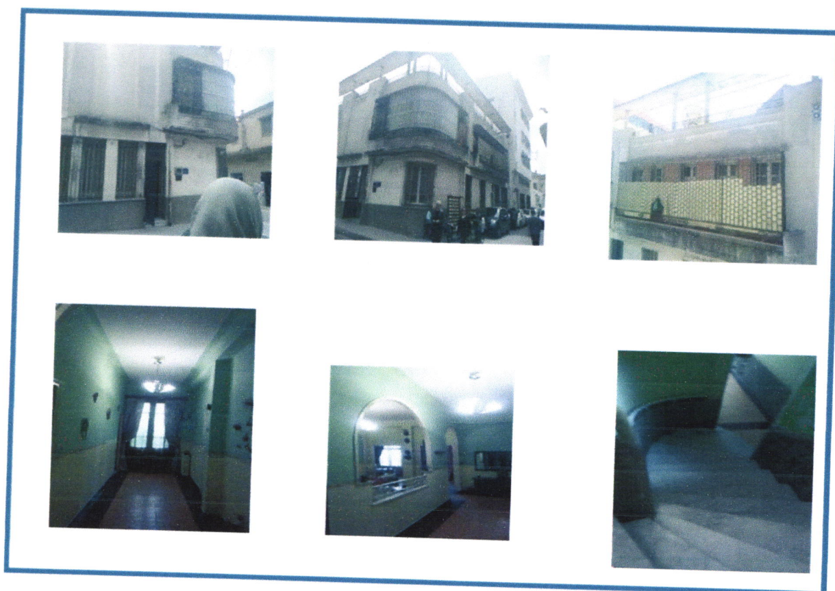
Figure 43 photo de la maison
