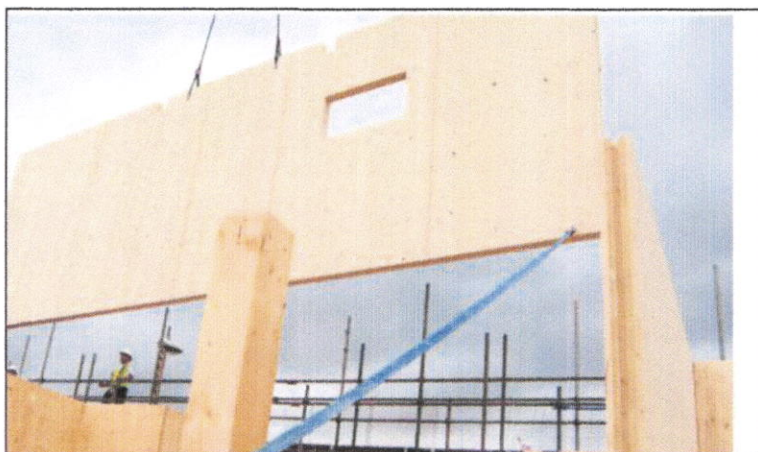
Figure 4 : Assemblages Panneaux CLT Source : Guide panneau CLT
