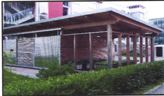
Figure18 : Abri vélos et poubelles. Vauban, Fribourg (All.).
