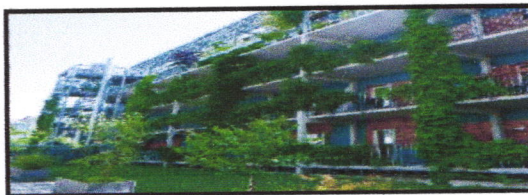
Figure 12 : façade nord, Bâtiment passif : conception bioclimatique. Quartier Vauban, Fribourg (All.)
