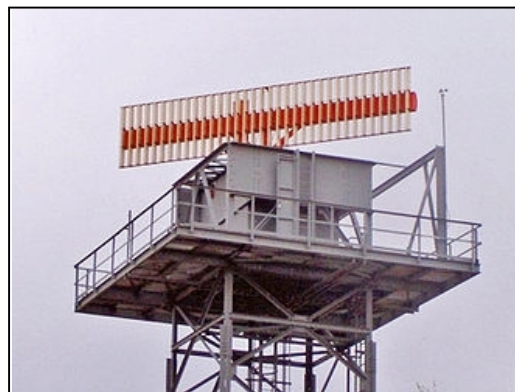
Figure I.6: Antenne SSR de contrôle militaire.
