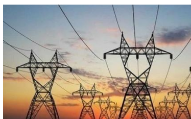
Figure 47 : Une centrale Électrique fonctionnant au Gaz Naturel avec une capacité de 100 MÉGAWATT, touchant plus de 97% du territoire de la wilaya.
