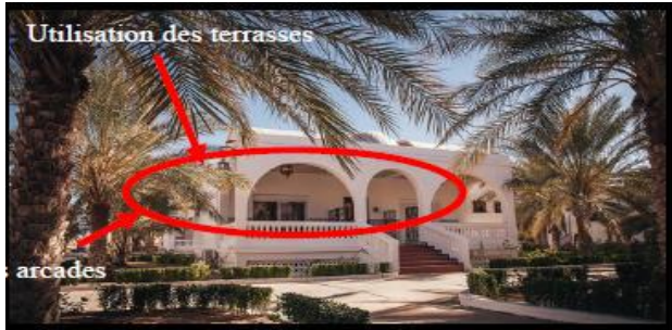
Figure 18 : Façade d'une villa Source :
