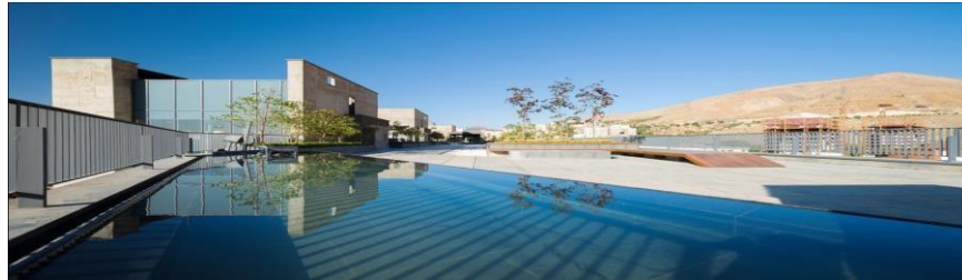
toiture terrasse Source : archdaily
