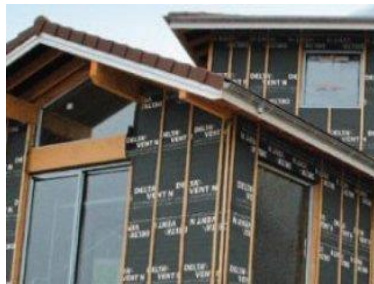
Photo : un pare-pluie sur la façade Source : Site web
