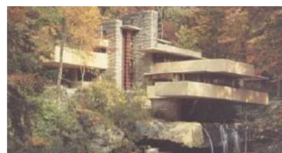
Figure 6 : Maison sur la cascade de F.L. Wright
