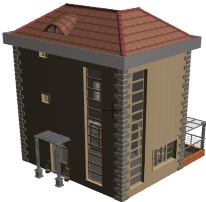
Façade Nord Est
