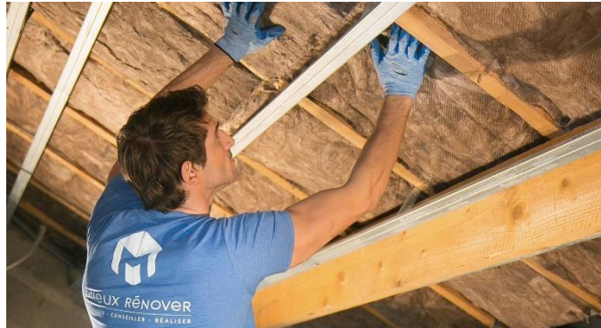
Photo : la laine de verre à l'extérieure Source : Site web
