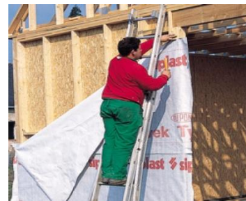
Photo : une façade protégée. Source : Site web
