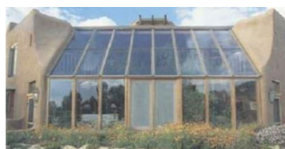
Figure 7 : Maison bioclimatique réalisée par William Lumpkin Balcomb Source : fshs.ummo.dz
