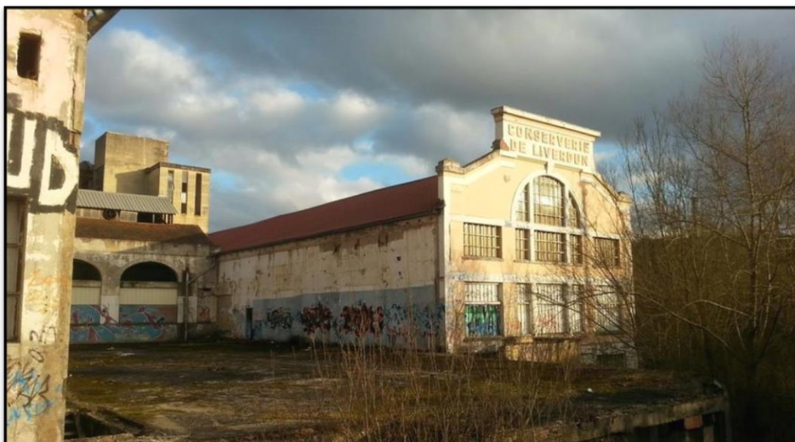
Figure 2-5 Friche industrielle ex : confiturerie Lerebourg Source : photo prise par Isabelle Baudriller
