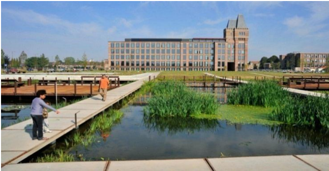
Figure 2.12 : Vue sur le quartier Rives de la Haute Deûle
