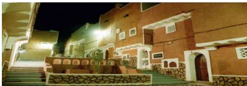
Figure 4-12: l'état du cadre bâti. Source : http://tafilelt.com/site
