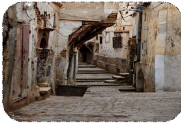
Figure 1-14: Photo de la Casbah d'Alger. Source : https://commons.wikimedia.org/wiki/File:Casbah_-_Alger.jpg
