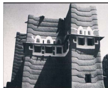
Figure 3-6 : Eléments horizontaux, pour l'ombre, Yémen. (Source: Dethier Jean, 1986, p39).
