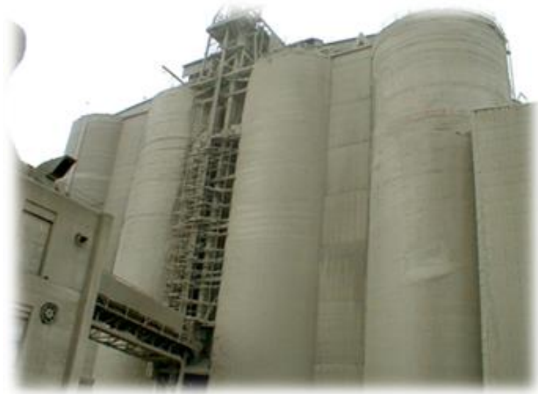
Figure 1.3 : Silos de stockage de clinker et gypse
