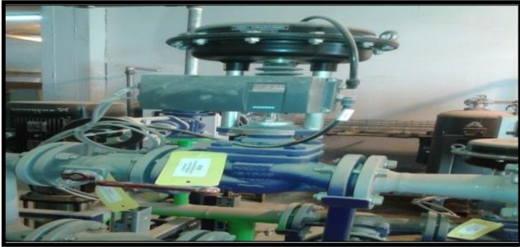
Figure 2.3 : Vanne proportionnelle
