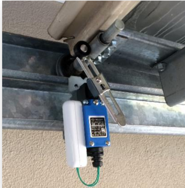
Figure 53 capteur fin de course fonctionnement
