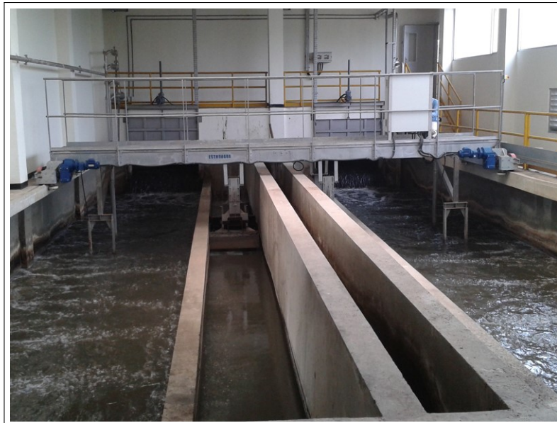
FIGURE I.7 – Le dessablage et le déshuilage[5]
