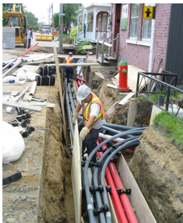
FIGURE 1.15 – Les câbles électriques souterrains [2].
