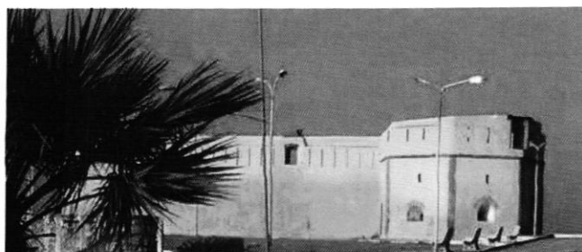
Figure 1 fort de l'est (Source : Photo prise par l'auteur)
