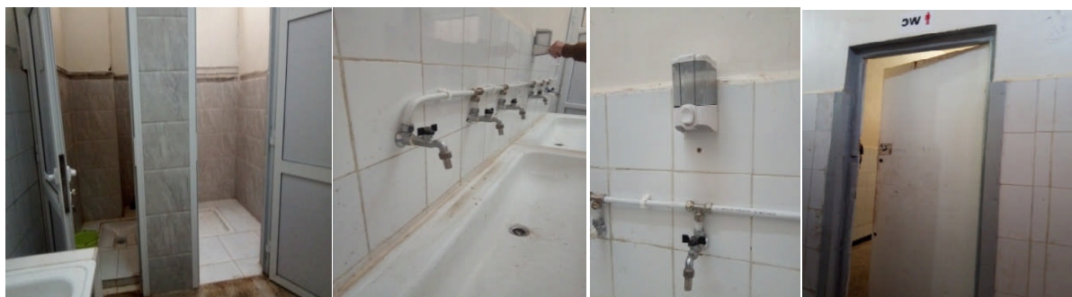
Figure 08 : sanitaires au niveau de restaurant de la cité 2 des garçons de BLIDA1.
