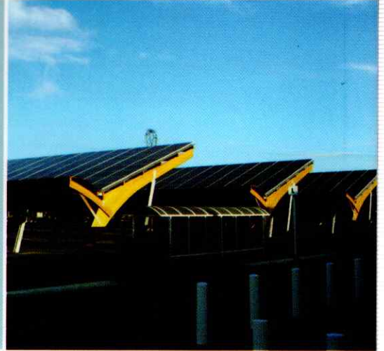
Inaugurée en 2008 à Saint-Aunès (Hérault), cette ombrière photovoltaïque dont la production est injectée au réseau électrique présente une surface de captage de 8000 m 2 . (photo des auteurs)
