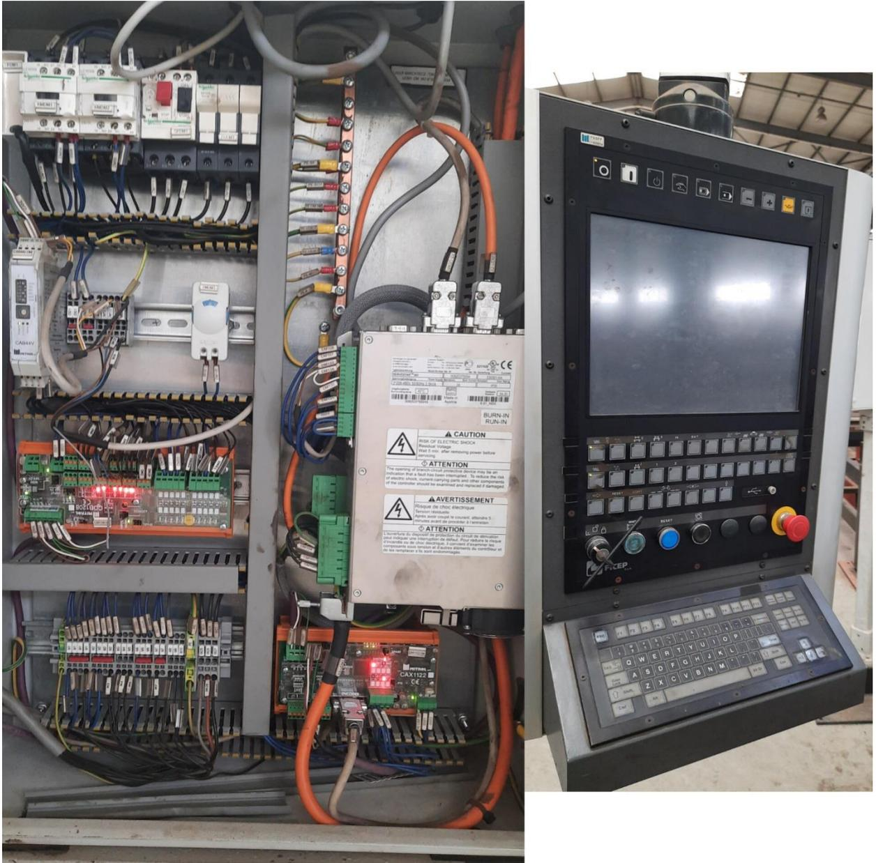
Figure 4 - 6 image réelle du câblage (CNC avec L'armoire)
