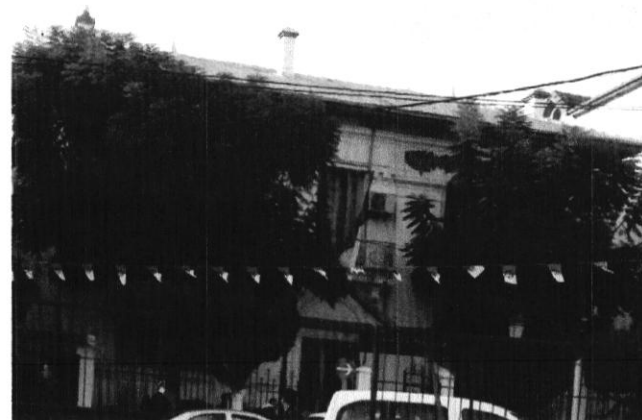
Photo 4.5 APC de Zéralda
