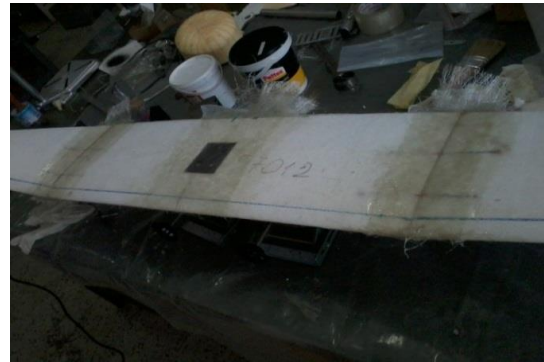
Fig. 6-26 : Renforcement des jonctions
