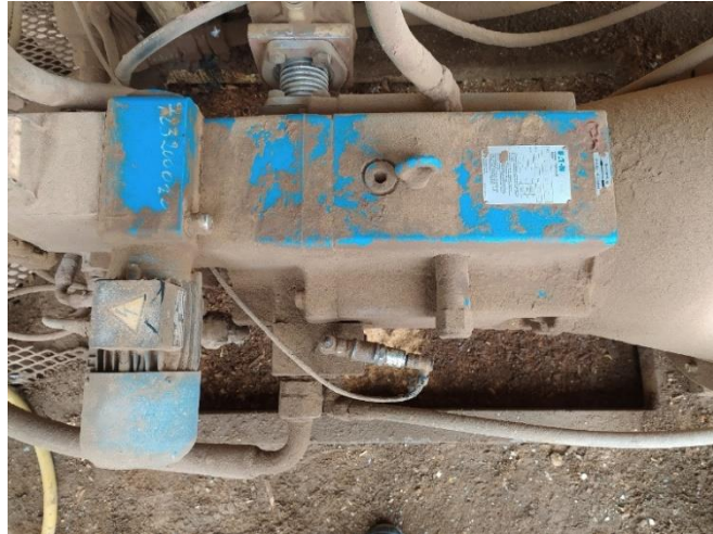
Figure 2.4 : Registre régulation débit du CENTREX
