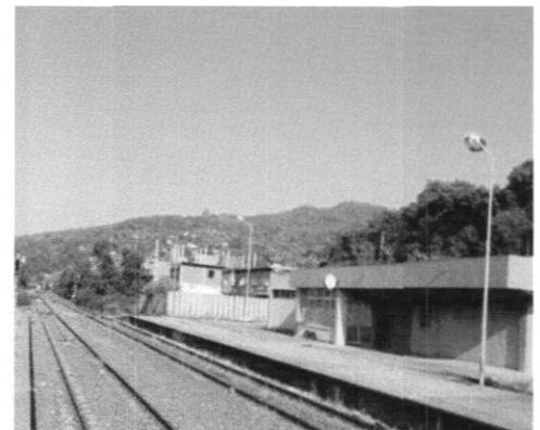
Photo27 : vue sur gare ferroviaire
