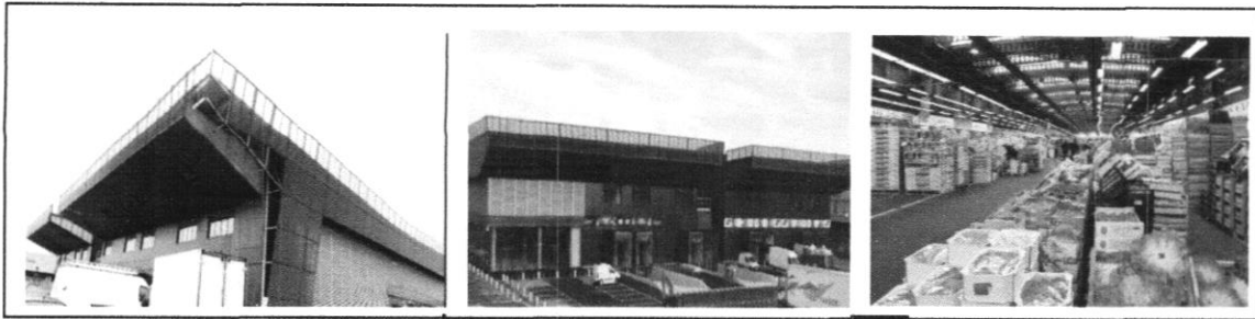
Photo 38: vue sur le batiments bio Source :google image
