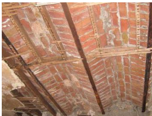
Fig. 33 et Fig. 34: Planchers à voutain. Source : Photographie actuelle prise par Auteur.
