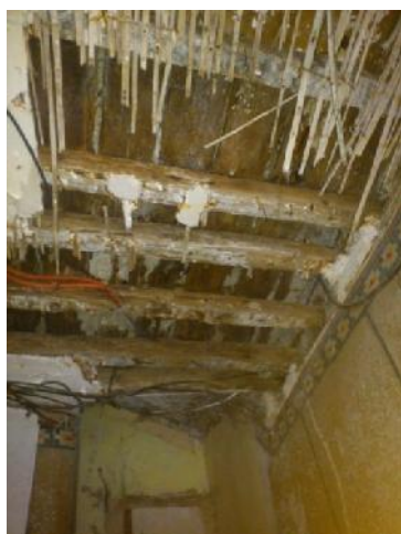
Fig. 31 et Fig. 32 : Planchers en bois à solives. Source : Photographie actuelle prise par Auteur.
