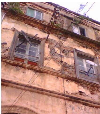
Fig. 23: Façade en moellons. Source : Auteur Fig. 24: Mur en brique. Source : Auteur
