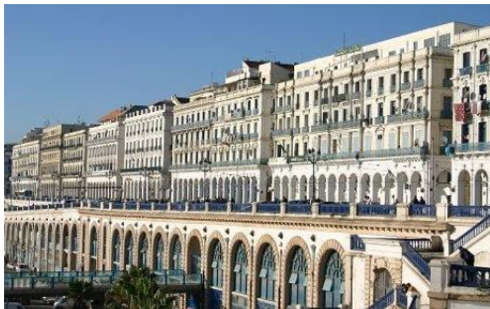
Fig. 5 : La façade de front de mer d'Alger. Source : COHEN J.L., OULEBSIR N., KANOUN Y., « Alger, paysage urbain et architectures 1800-2000 », éd. de l'imprimeur, 2003.
