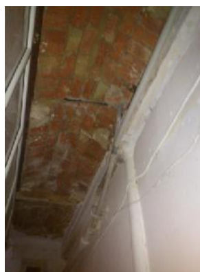
Fig. 33 et Fig. 34: Planchers à voutain. Source : Photographie actuelle prise par Auteur.
