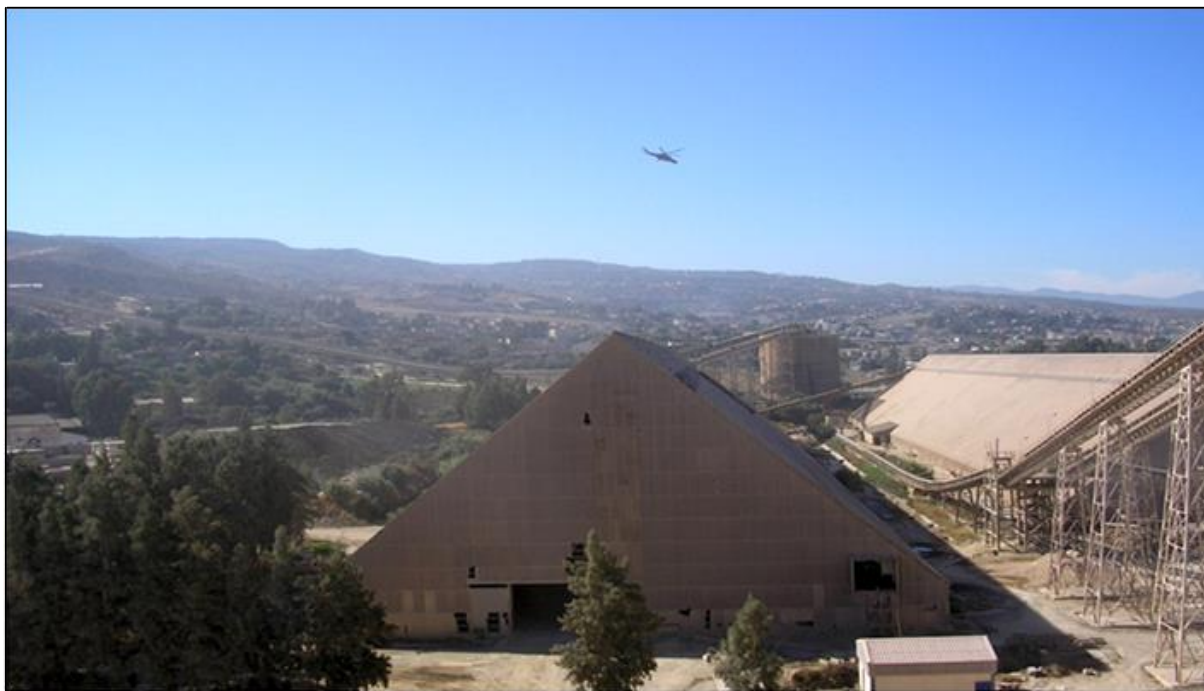
Figure I.6 : Hall de pré homogénéisation.
