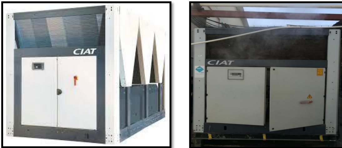
Figure 2.1 : le refroidisseur d'eau de la marque CIAT.
