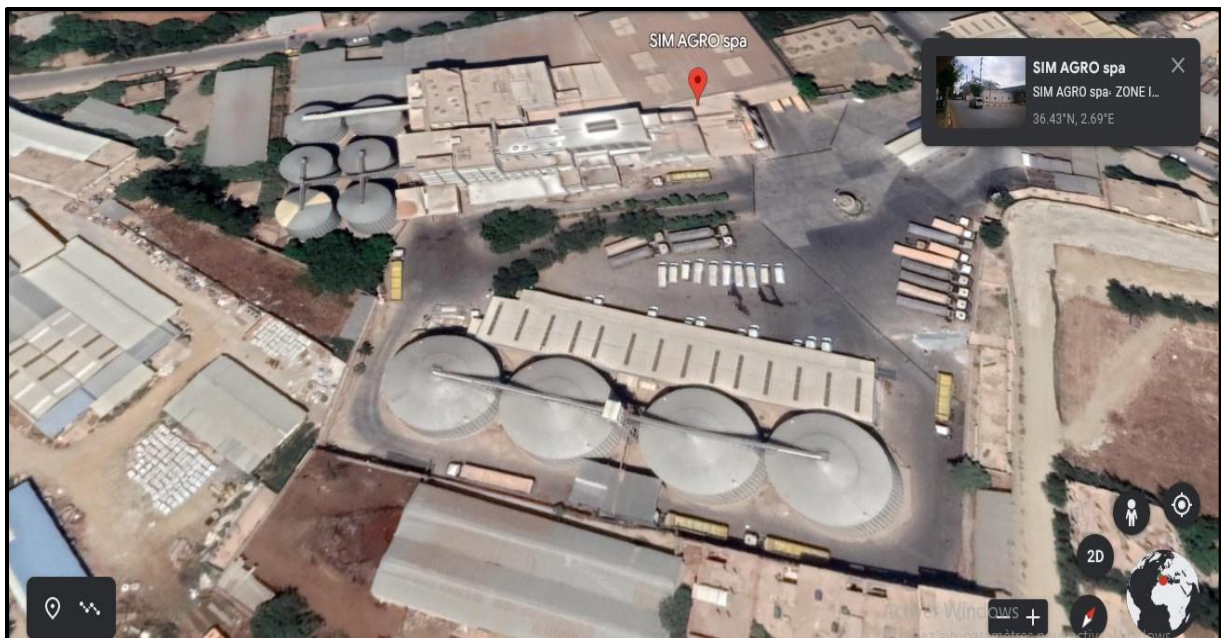
Figure 1.1 : Entreprise SIM Algérie vue ciel [2]
