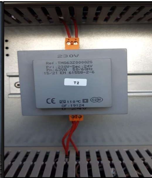
Figure 2.25 : Transformateur (230V→24V)
