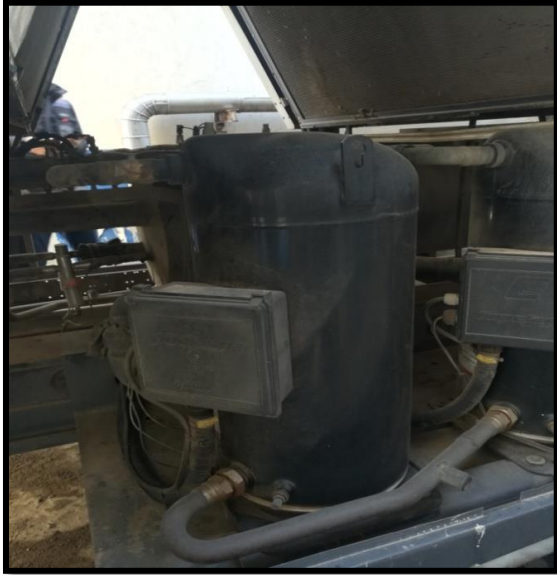
Figure 2.5 : le compresseur scroll
