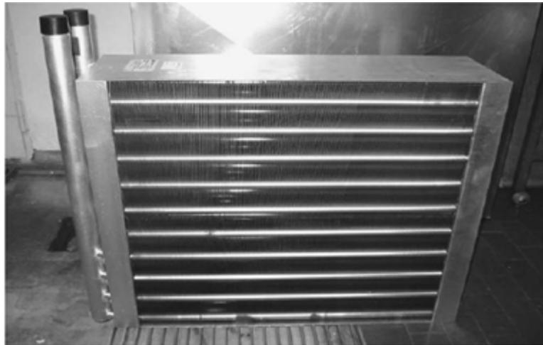
Figure 1.21 : Echangeur de chaleur à tubes et à ailettes
