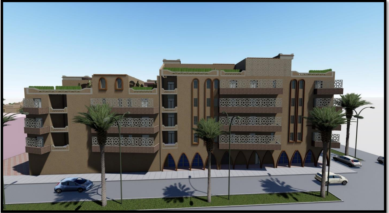
fig.72 : Façade principale du collectif Source : auteurs
