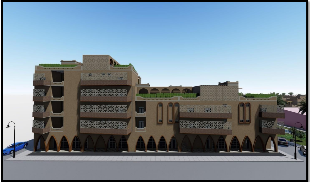
fig.74 : Les ouvertures de la façade principale du collectif Source : auteurs
