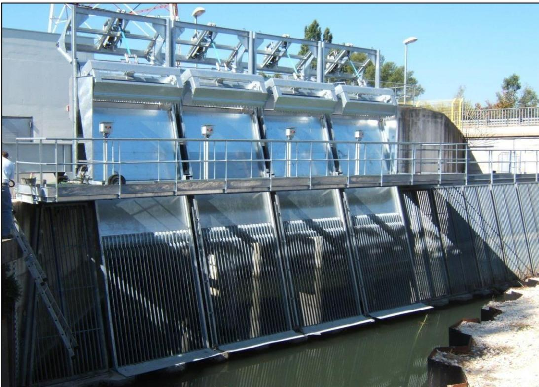
**Figure I.5 :** Dégrillage fin.
