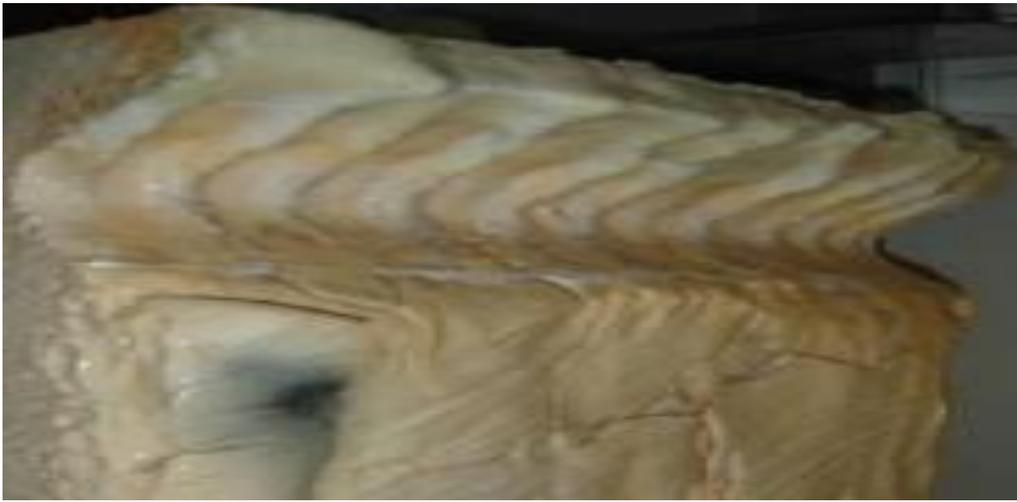
*Figure III.1 : Photo montrant la corrosion des briques "coups de sabre".*
