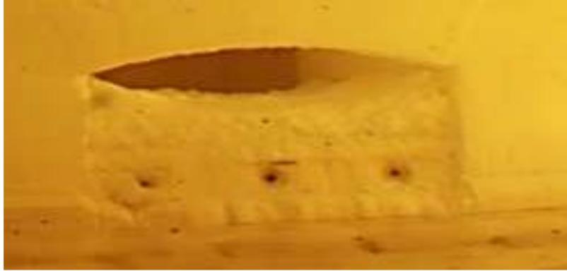
*Figure III.2 : Blocage d'ouvertures de régénérateur.*
