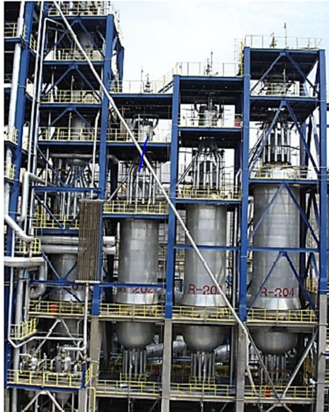
Figure III.5 : Les 4 réacteurs de reformage catalytique
