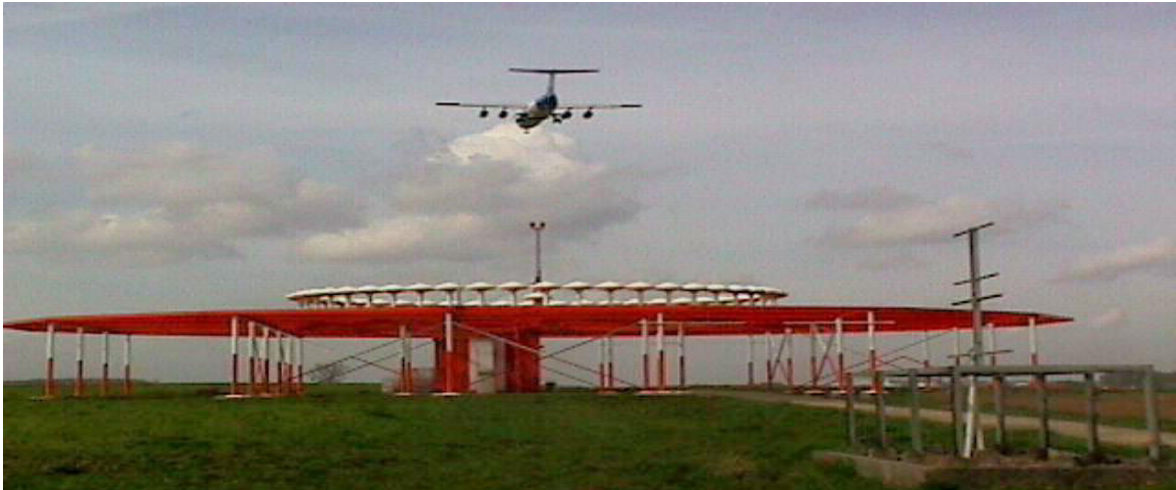
Figure 1.4 : Exemple d'un équipement de navigation VOR/DME.
