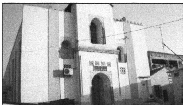
FIG 02.20.03:Façade de la mosquée.
