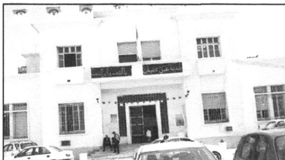
FIG 01.20.03:Façade de l'A.P.C.
