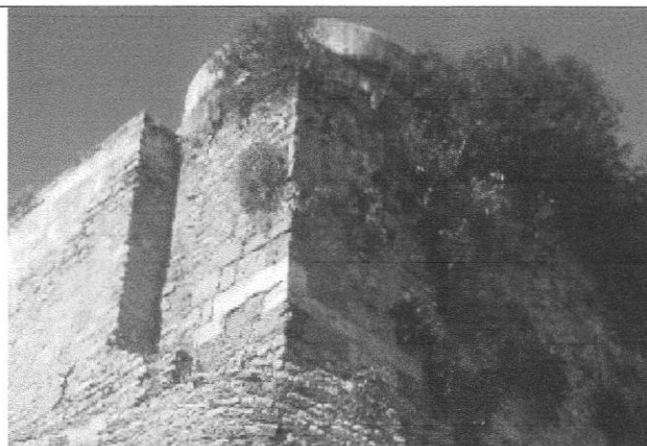
Figure 36 : Chaine d'angle en pierre de taille. 59
