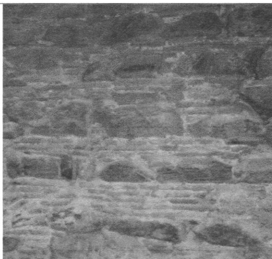
Figure 32 : Mur intérieure : opus Mixtum à bandes. 55
