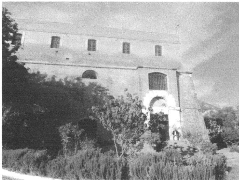
Figure 65 : Vue sur la façade sud du Fort Moussa 91 .
