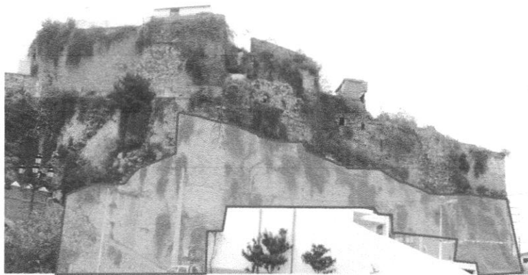
Figure 34 : Soubassement dans la façade sud-ouest. 57
