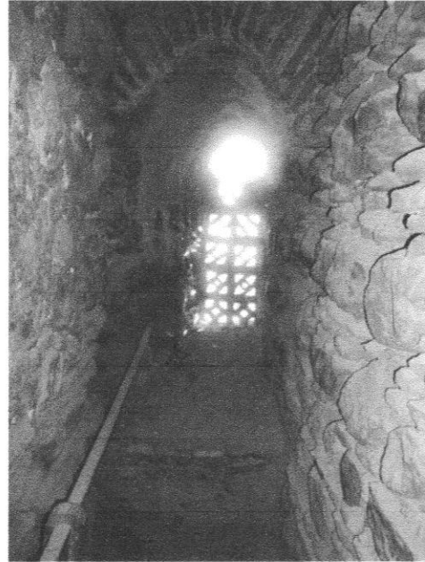
Figure 44 : Ouverture en arc surélevé. 67
