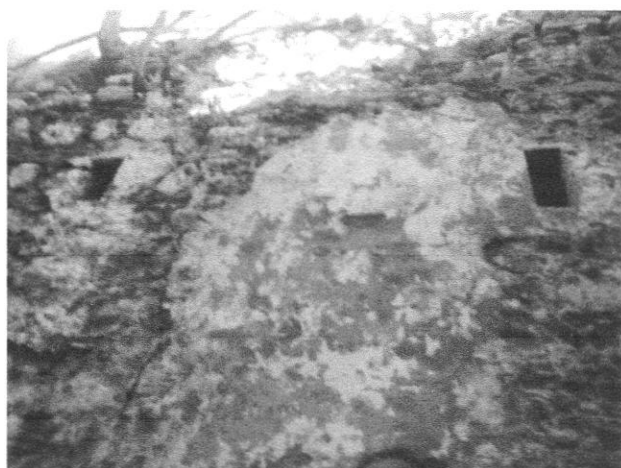
Figure 56 : Ouvertures percées dans la muraille. 79
