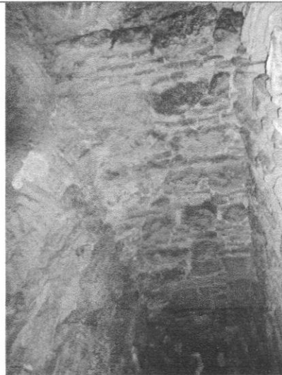
Figure 54 : Couverture en moellons avec briques. 77
