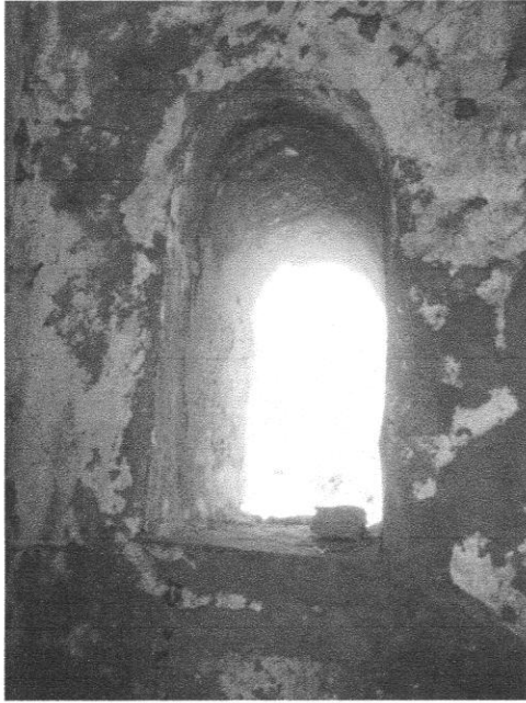
Figure 43 : Ouverture en arc surélevé. 66
