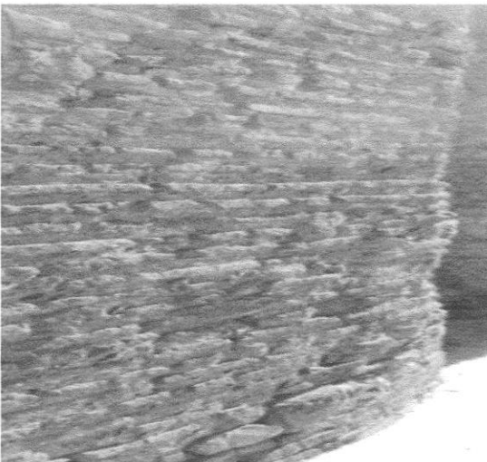
Figure 18 : Partie de la muraille en brique pleine.
