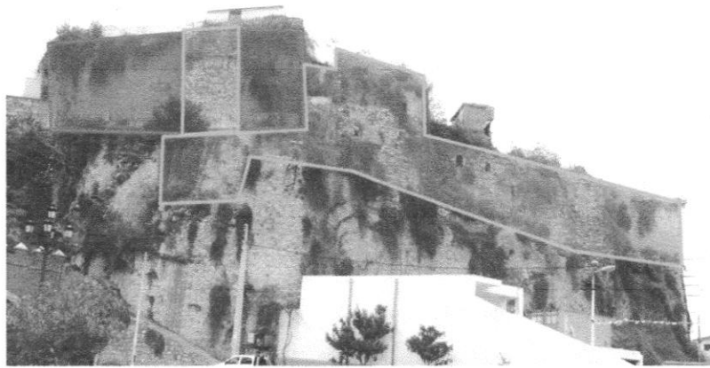
Figure 25 : Photo de la façade sud-ouest.
