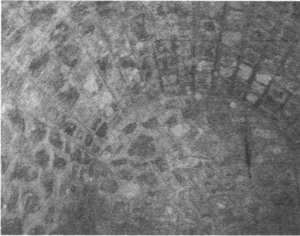
Figure 16 : Couverture et mur en moellons.
