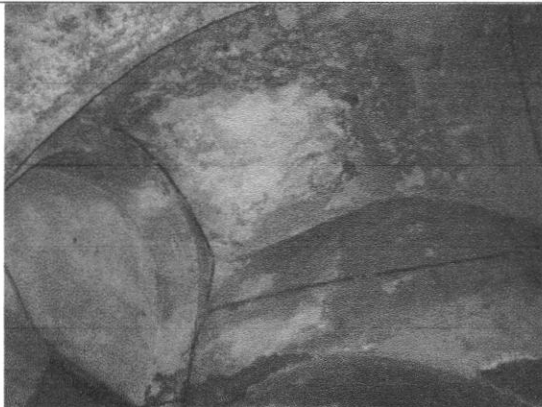
Figure 39 : Couverture en voute d'arêtes. 62
