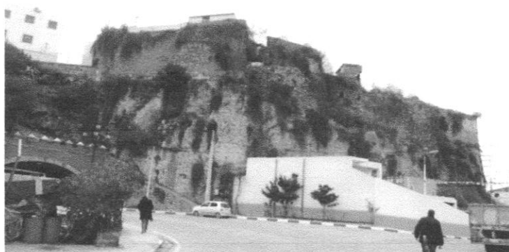
Figure 24 : Vue vers la muraille du côté Sud-ouest. 47
