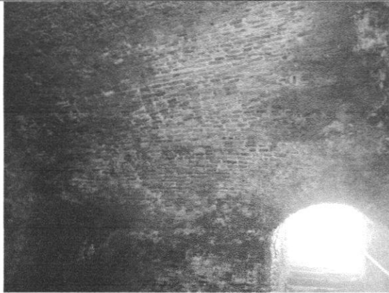
Figure 37 : Couverture en voute en plein cintre. 60
