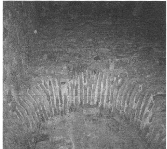
Figure 19 : Ressauts des arcs en brique pleine.
