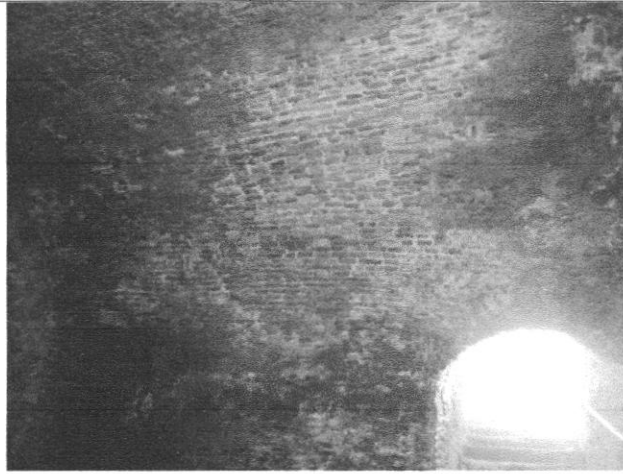
Figure 53 : Couverture en voûte en brique pleine. 76
