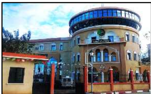
Figure3.61 : bâti en bon état Source : photo prise sur terrain
