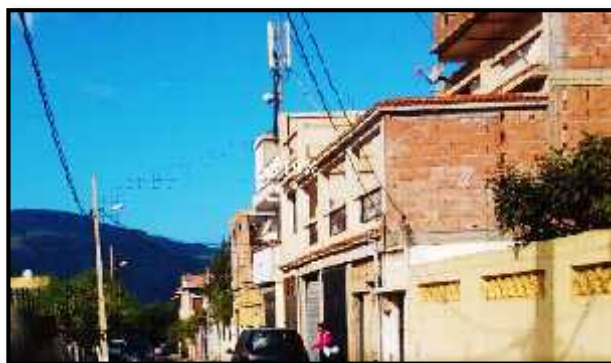
Figure3.62 : bâti en moyen état Source : photo prise sur terrain
