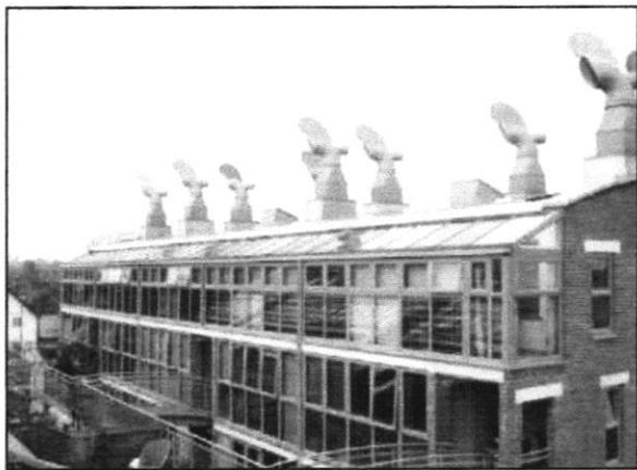
Figure 17 : Ventilation par tirage thermique ; source <sup>4</sup> : (82 logement Grande Bretagne) "Ventilation et menuiserie", in CSTCmagazine, hiver 1999, pp.21-30
