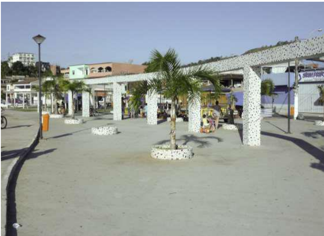
Une nouvelle place et des équipements sportifs ont été aménagés comme levier de régénération de la favela.
