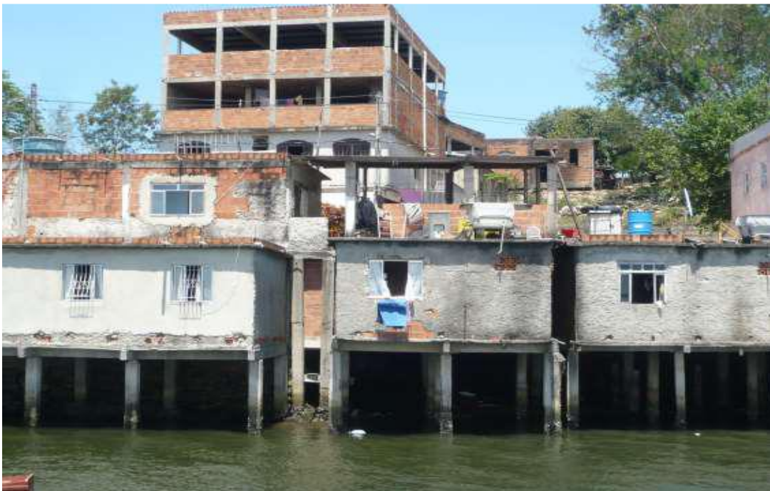
Habitat irrégulier sur pilotis construit sur la mangrove de la baie de Vitoria.
