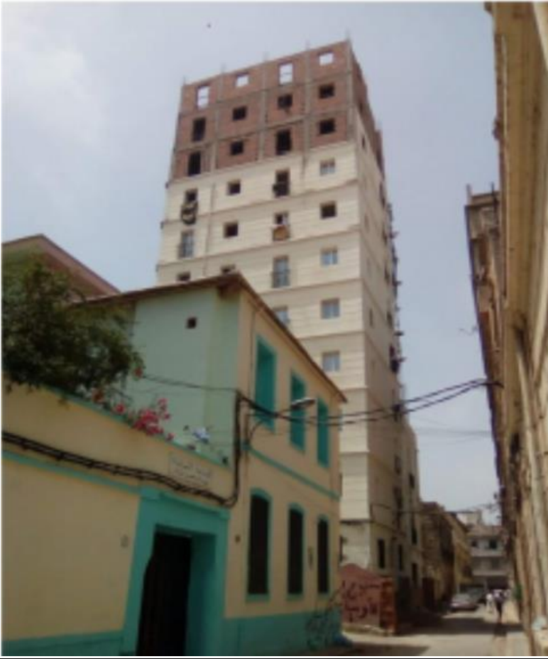
Immeuble d'habitation de 14 étages en cours de construction.
