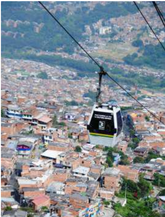
Le métro câble est un outil de requalification urbaine.
