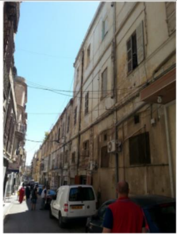
Construction délabrée et vidée sur la rue du Fondouck.
