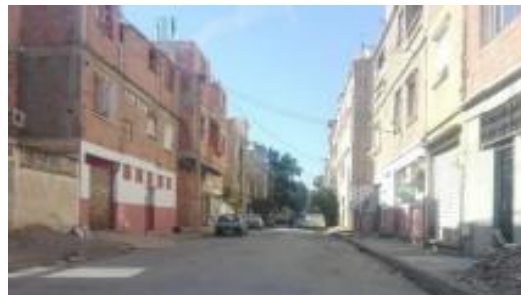
Photo du quartier 3 caves prise par les hauteurs:
