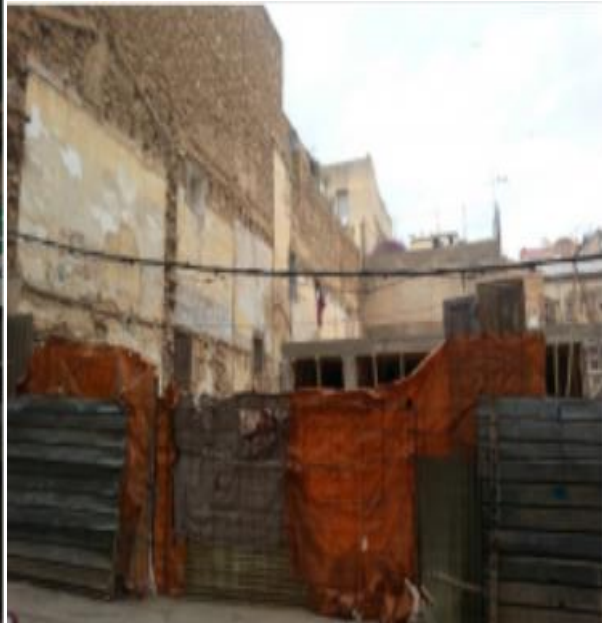
Installation d'un chantier pour la construction d'une villa.
