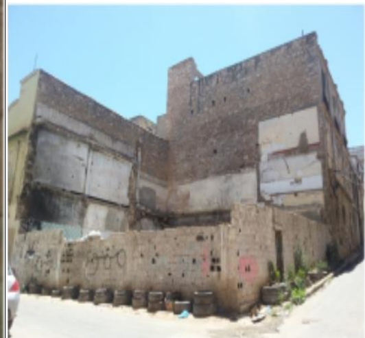
Démolition d'une ancienne bâtisse pour la construction d'une villa.
