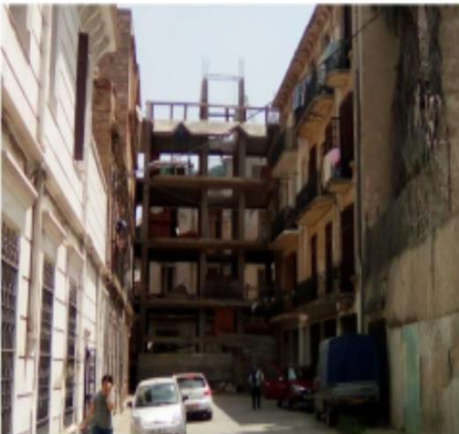
Construction en cours d'un immeuble à grande hauteur.
