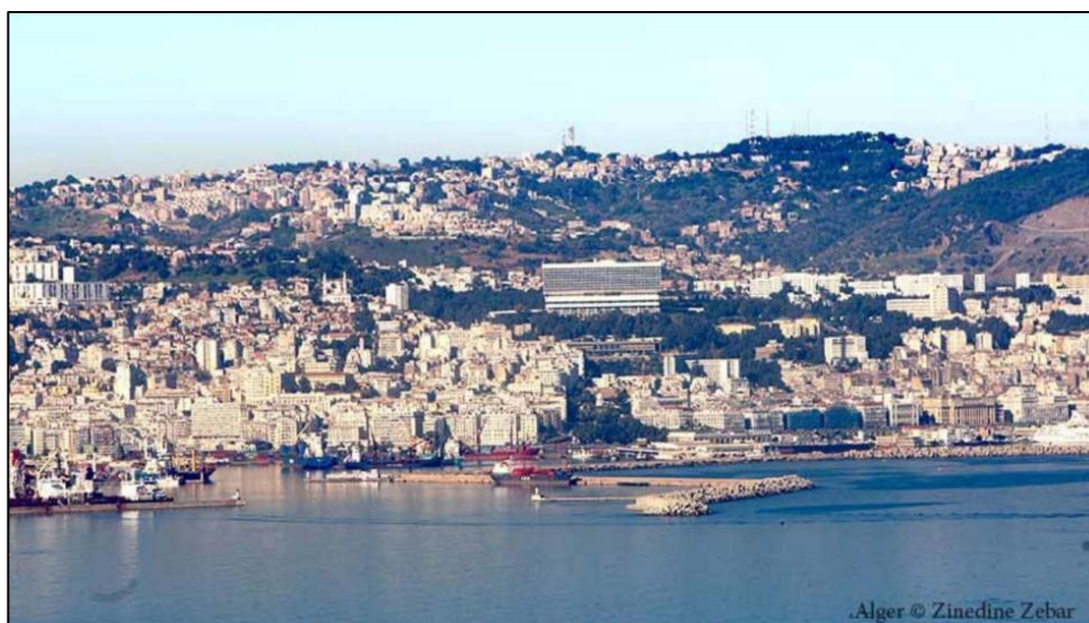
Figure 14 : Vue générale sur Alger
