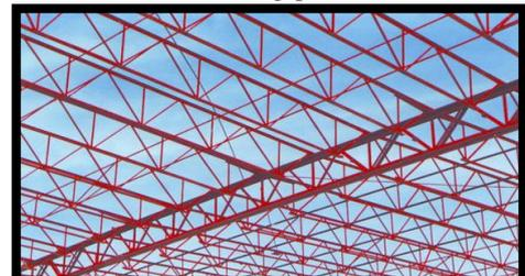
Fig176 : poutre treillis.
