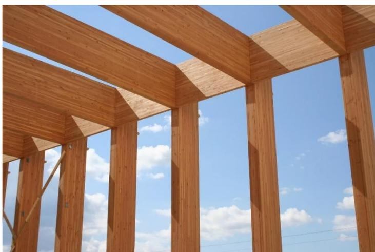
Figure 169 : structure poteau-poutre en bois lamellé collé.
