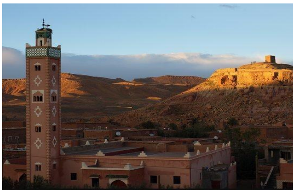
Figure I-12: La mosquée du ksar Source : rapport sur l'état de conservation des biens du patrimoine mondial
