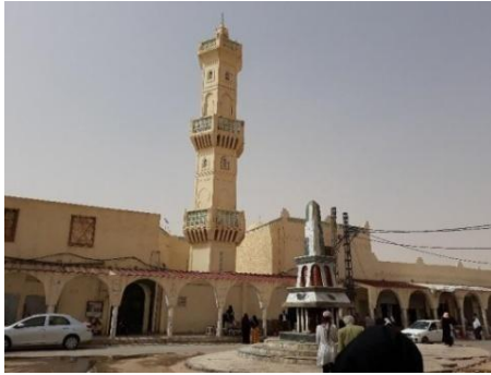
Figure II-16 La mosquée de Sidi Baafou À l'état actuel
