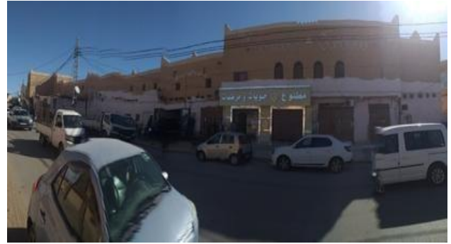
Figure II-17 Photos montrant la façade réhabilitée au Ksar de Ouargla
