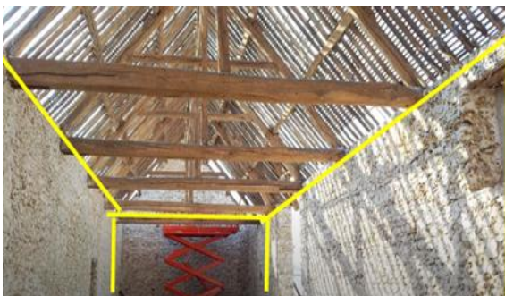
Figure 35 : Photo montrant les murs de la ferme.
