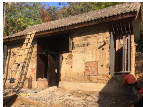
Figure 68 : Photo montrant l'état du mur après la rénovation. Source : Arch Daily.
