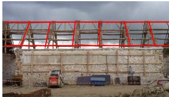
Figure 28 : Photo montrant la charpente en bois. Source : Arch Daily traité par auteur.
