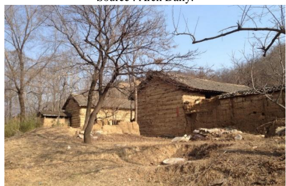
Figure 42 : Photo montrant l'état de bâtis après l'incendie de l'incendie.
