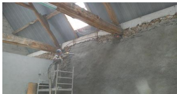
Figure 31 : Photo montrant la dépose du béton de chanvre. Source : https://www.bcb-tradical.com/portfolio/maison-des-etudiants-campus-de-marne-la-vallee/
