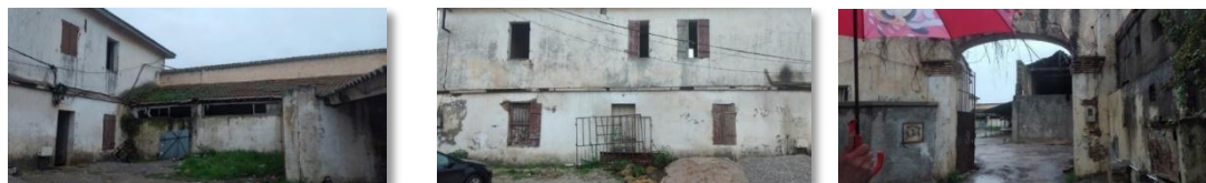
Figure 119 : Photos montrant la Ferme commune de Réghaia wilaya d'Alger (2).
