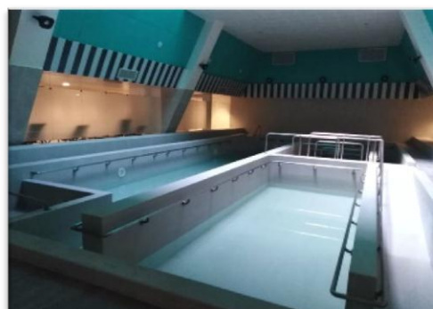
Figure 82 : Photo montrant la piscine d'intérieur. Source : https://thalassotherapie.dz/
