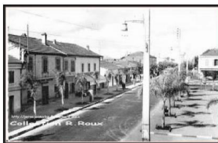
Figure 130 : Image montrant Réghaia, vue du noyau colonial.
