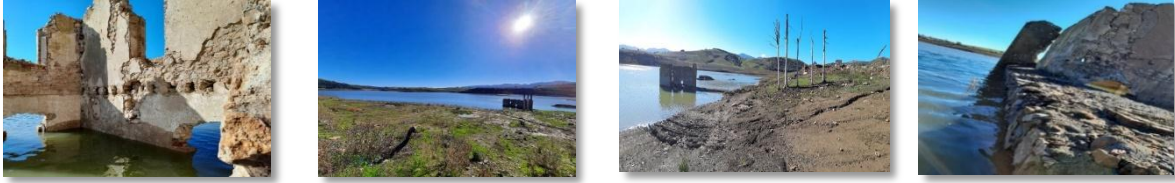
Figure 120 : Photos montrant la ferme Sidi Amar commune de Hadjout Wilaya de Tipasa. Source : Par auteur.
