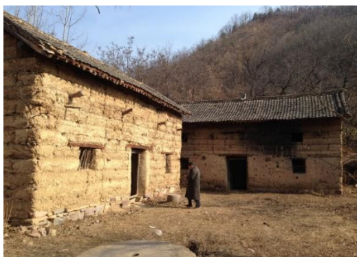
Figure 41 : Photo montrant l'état de bâtis après l'incendie de l'incendie.
