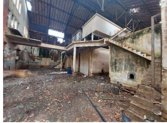
Figure 60 : Le Hall d'entrée avec la double hauteur en RDC « Source : Auteur »
