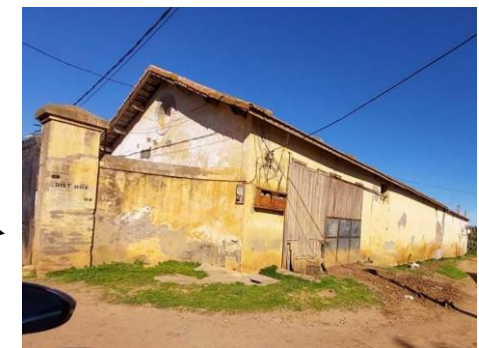
Figure 17 : Hangar « Source : Auteur »
