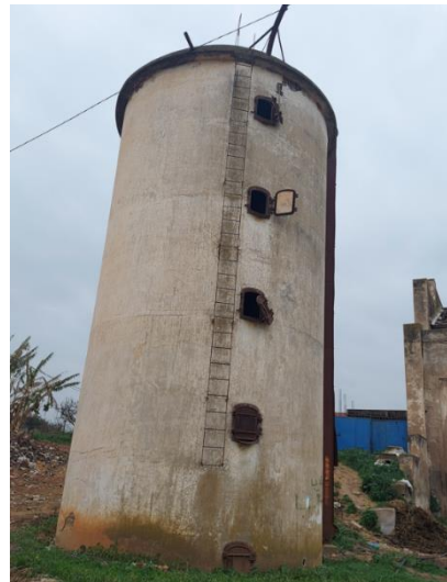
Figure 21 : Silo « Source : Auteur »
