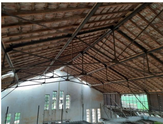
Figures 53 : La partie centrale de la charpente métallique de la cave coopérative « Source : Auteur »
