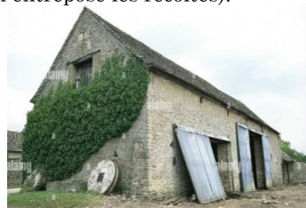
Figure 19 : Ancienne grange en pierre rustique
