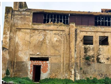
Figure 98 : Vitre cassée / Ouverture redimensionnée « Source : Auteur »
