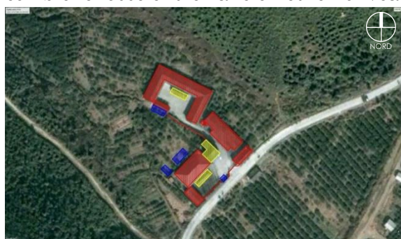
Figure 25 : Action d'intervention sur site en 2009 « Source : Traitée par : Auteur »
