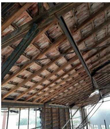
Figure 70 : La toiture en tuile posé sur la charpente métallique « Source : Auteur »
