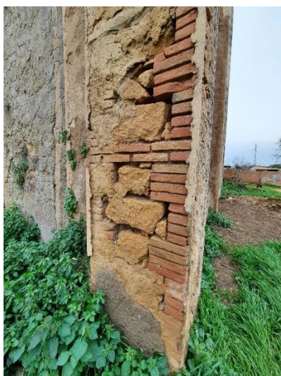
Figure 49 : Poteau d'angle (85x85cm) « Source : Auteur »
