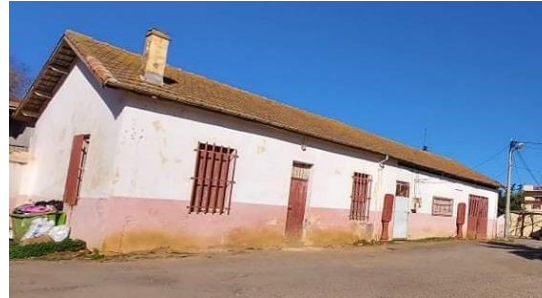
Figure 12 : Bâtiment ouvrier + Etable « Source : Auteur »
