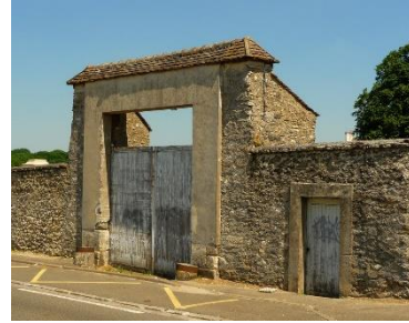
Figure 23 : Porche d'entrée ferme de Gally
