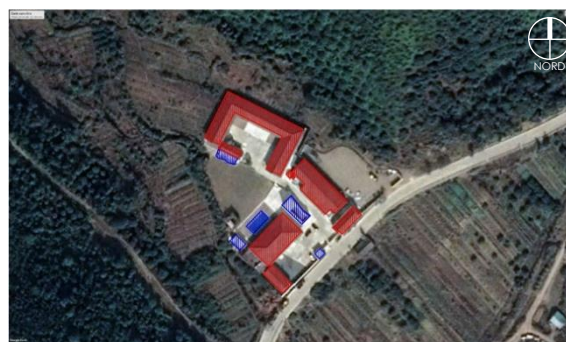
Figure 26 : Action d'intervention sur site en 2017 « Source : Traitée par : Auteur »
