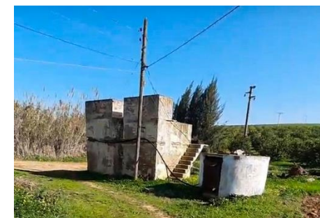
Figure 42 : Sulfaterie + Puit « Source : Auteur »
