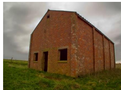
Figure 21 : Vue extérieure d'un hangar en pierre
