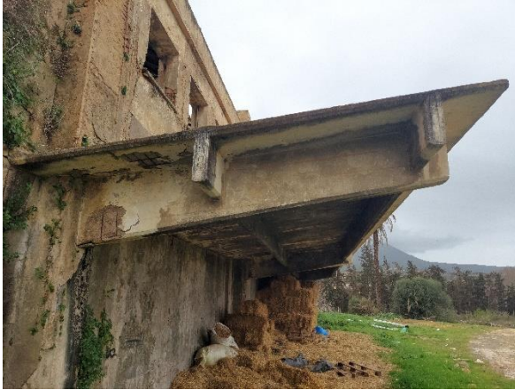
Figure 63 : Vue de dessous du porte à faux « Source : Auteur »
