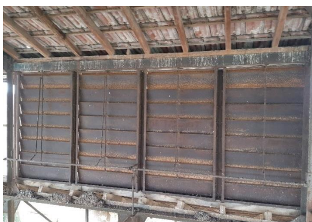
Figure 71 : La toiture en tuile posé sur les claires voies « Source : Auteur »
