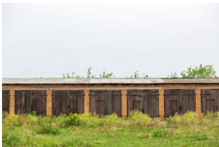
Figure 20 : Vue extérieure d'une étable en brique
