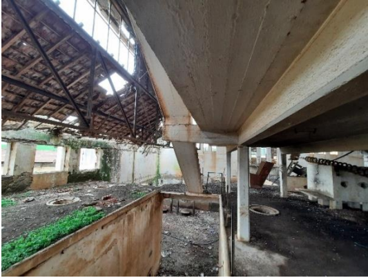
Figure 59 : L'assemblage de l'escalier préfabriqué « Source : Auteur »
