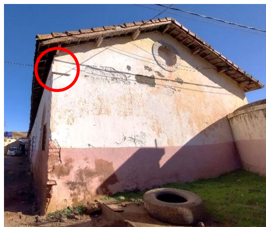
Figure 77 : Poteau d'angle avec ses éléments de rappel « Source : Auteur »
