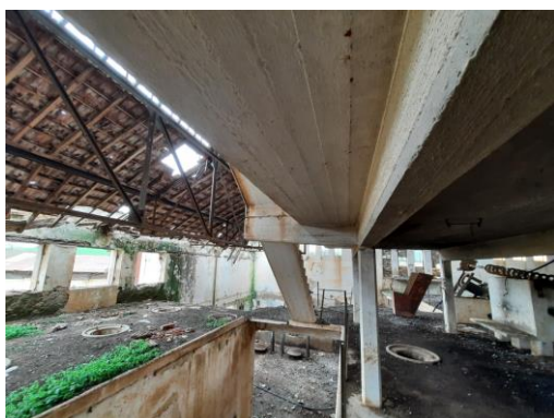
Figure 101 : Plancher haut en très bon état « Source : Auteur »
