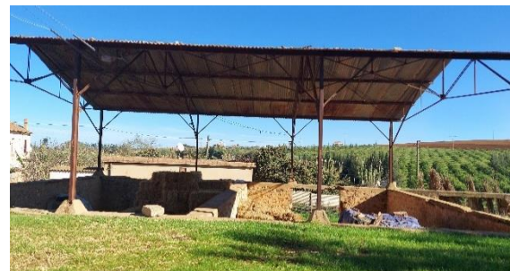
Figure 14 : Bassin d'arrosage « Source : Auteur »
