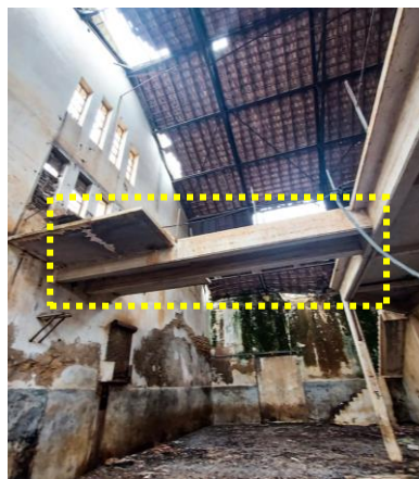
Figure 112 : Poutre interne en bon état « Source : Auteur »
