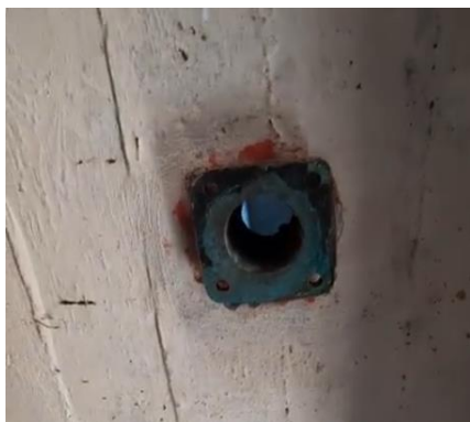
Figure 117 : Pièce de raccord de l'ancienne tuyauterie volée « Source : Auteur »
