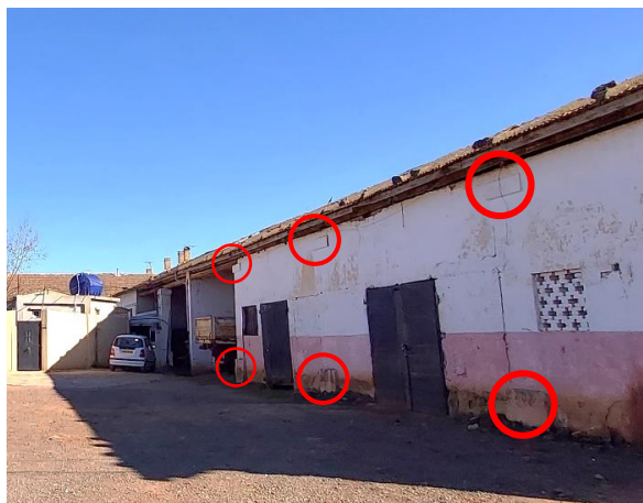
Figure 76 : Des éléments en saillies en haut et en bas des poteaux « Source : Auteur »
