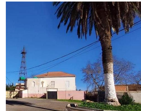
Figure 41 : Maison de maitre « Source : Auteur »
