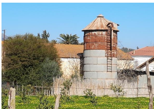
Figure 37 : Silo « Source : Auteur »
