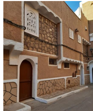
Figure 14 Façade extérieure Source : auteurs 2022
