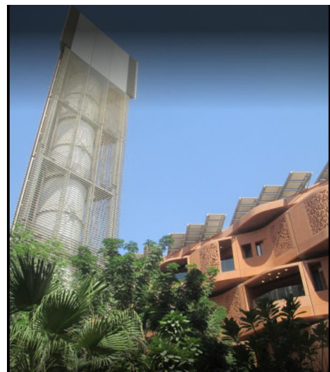
Figure 18 Tour de vent et facade de l'université
