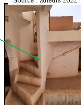
Figure II - 21 Escalier Source : auteurs 2022
