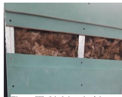
Figure III- 94 cloison intérieure en Placoplatre Source : Pris par les auteurs 2022.
