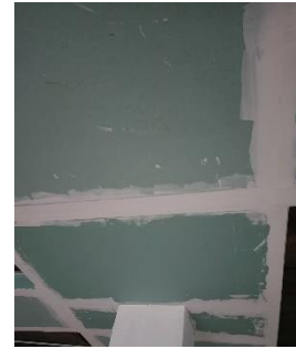
Figure III- 95 faux plafond en Placoplatre Source : Pris par les auteurs 2022
