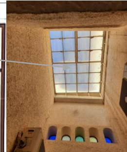
Figure 5 La courette Source : auteurs 2022
