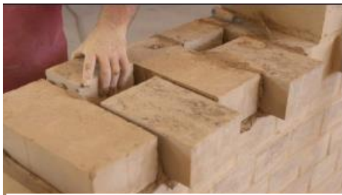
Figure 50: brique de terre compressée Source : Construction en BTC Myriam OLIVIER - Cayenne, Guyane, 11-15 avril 2016
