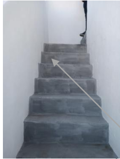
Figure 7 Les escaliers Source : auteurs 2022
