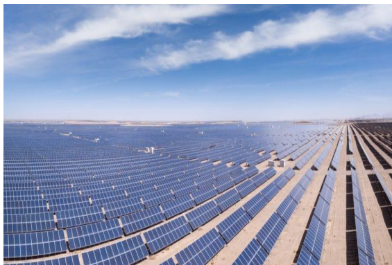
a) Champ des panneaux solaires
