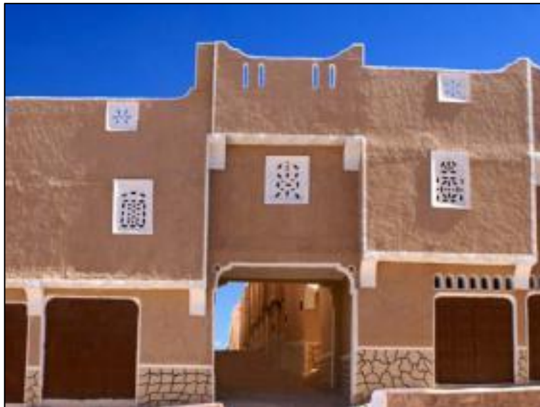
Figure : traitement de façade extérieur du ksar Tafilalet.
