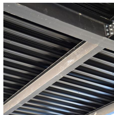
Figure 157 : plancher collaborant, source : https://www.pinterest.fr/pin/766808274029264284/
