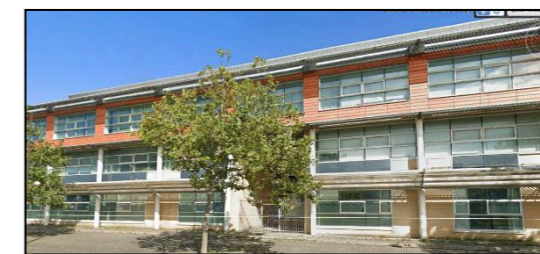
Figure 38 : Façade sud Source : google erth
