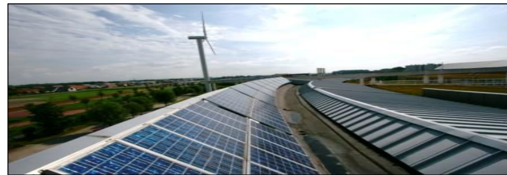
Figure 43: Capteur solaire et panneaux photovoltaïques Source: livre "l'architecture écologique"
