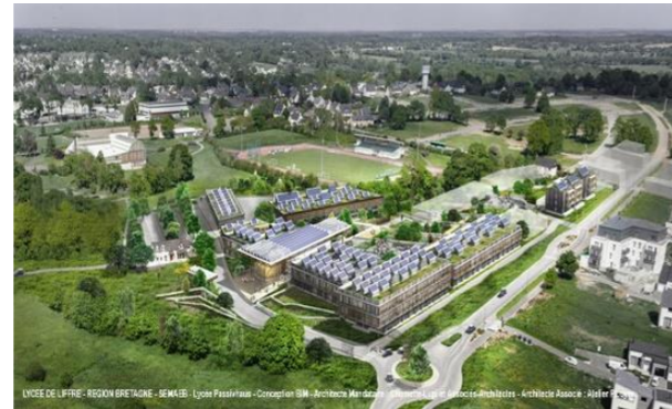
Figure 44: vue du lycée liffre Source : https://kiiwan.fr
