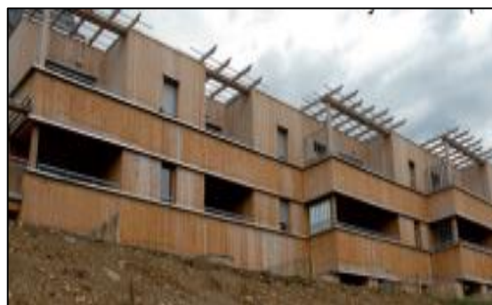
Figure 32 : Saint-Jean d'Arvey- ex.12 (73) – PATEY, groupes de bâtiments linéaires.
