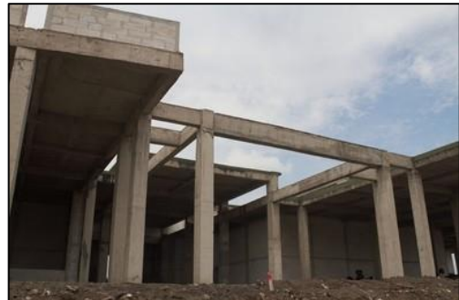
Figure 95 : système structurel poteaux poutres.
