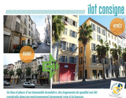
Figure 07: réhabilitation des façades et requalification des logements.
