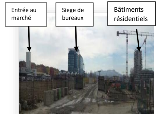
Figure22 : Image panoramique du site en construction ( mai 2012)
