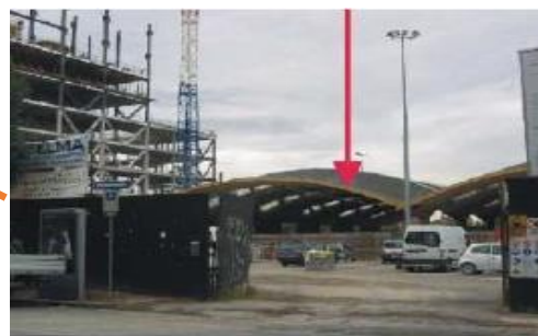
Figure 20: La Pensilina Nervi construite dans les années 1950
