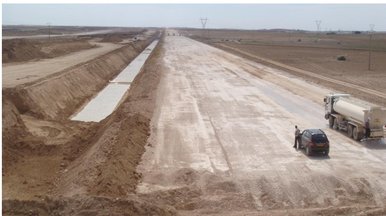
Photo n° 11: Etat d'avancement des voiries
