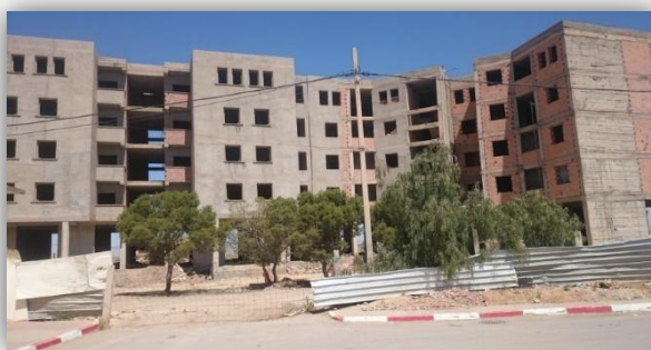
Photo 10 : 98 logts en cour de réalisation
