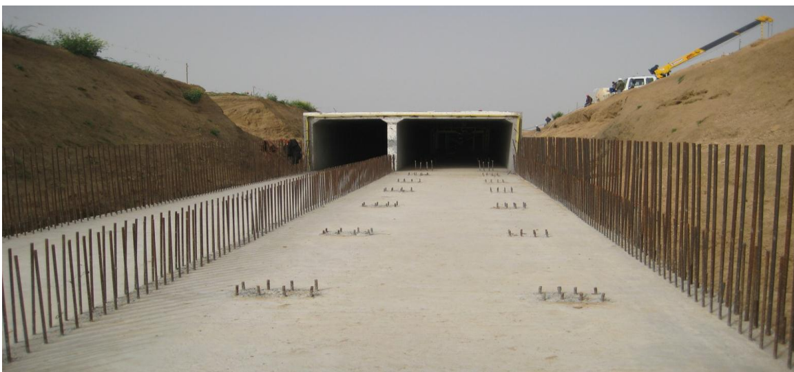
Photo n° 12: Etat d'avancement Galeries techniques
