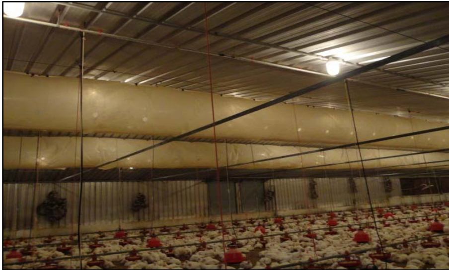
Figure N°11: Vue de l'intérieur d'un batiment équipé de fan jet .
